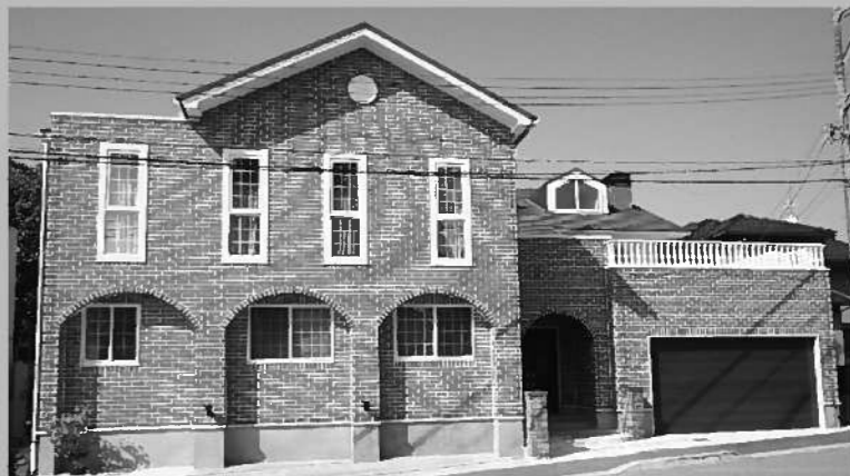
↑増築した住宅側玄関。当社輸入住宅の楼瓦を貼り、重厚感のある仕上がりに。
