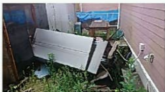
建物は無事でも給湯器の転倒が多数みられました
